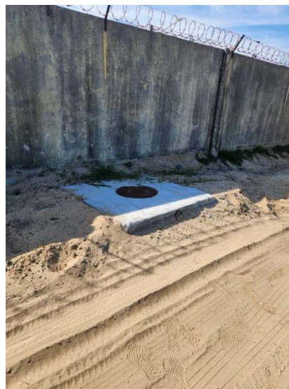
Imagem 12 – Fotos das caixas de passagem da rede de dutos em Navegantes
