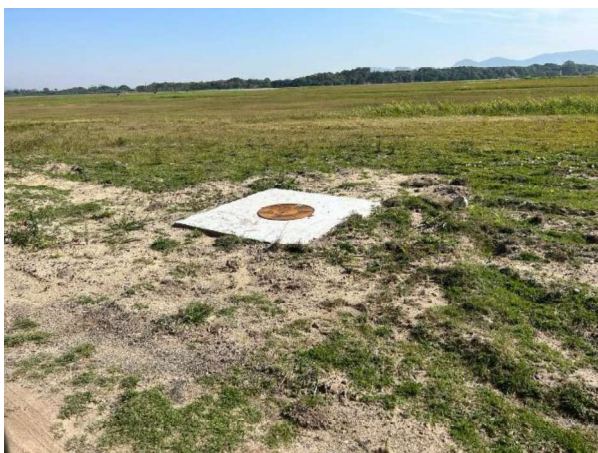
Imagem 12 – Fotos das caixas de passagem da rede de dutos em Navegantes
